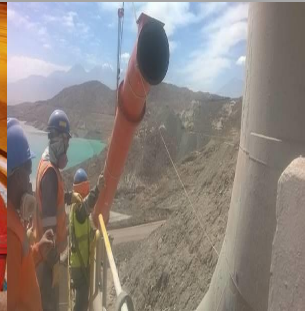
Cambio de Tuberías Trelex
