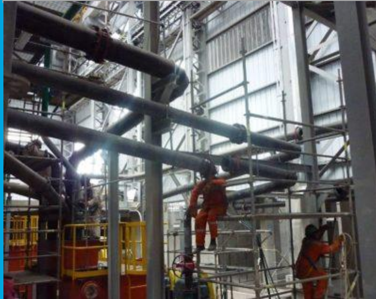
Mantenimiento de Tuberías Limpieza de Tuberías
