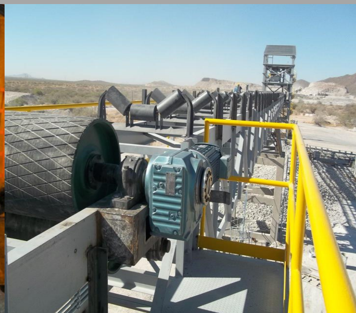
Mantenimiento de Motorreductores en Fajas Transportadoras
