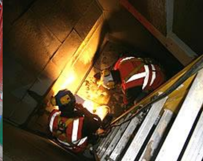
Mantenimiento de Chutes
